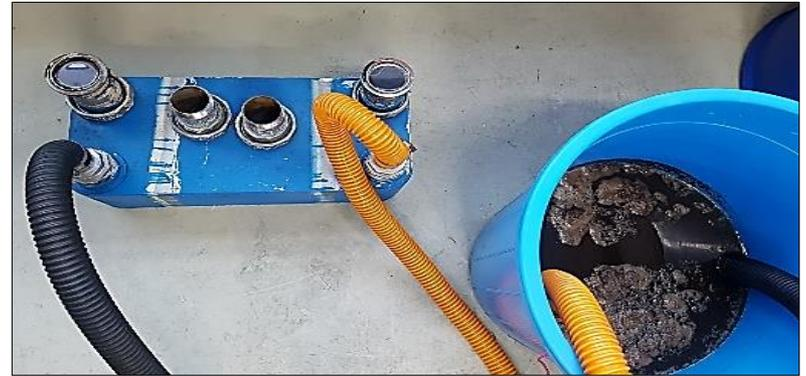
냉각수 입, 출구 측에 가설 호스를 연결한 후 선정된 세정제를 주입 및 배출을 연속적으로 시행합니다. 순환 용량은 열교환기 용량의 약 4배 가량이며, 순환 시간은 일반적으로 2~3시간입니다. (세정 중 결과를 확인하기 위해 호스를 분리하고, 입출구 측의 세정 상태를 확인 후, 미흡하면, 신액으로 교체하여 추가 세정을 실시하고, 완료 후 용수로 수세하여 세정 작업을 완료합니다.
