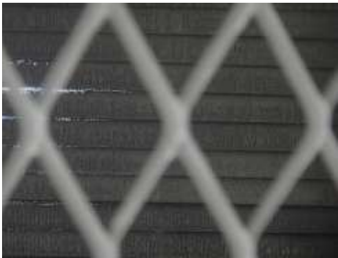
Before cleaning : tube 열 사이로 빛이 통과 되지 못함
