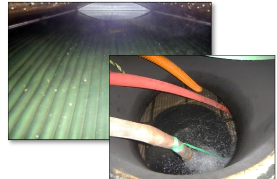
Fill & soaking 화학 세정 방법
