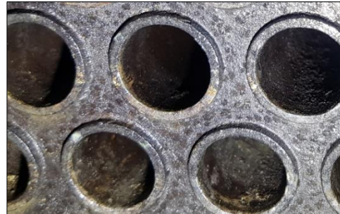
Tube pigging 후 스케일이 잔류된 모습
