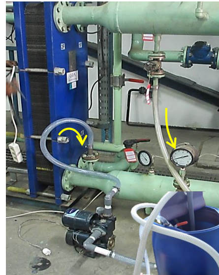
열교환기 In Out에 임시 순환 Hose를 연결하여 세정 하는 모습
