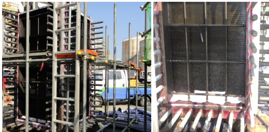
<그림 6> 부적합 detergent로 세정 후 결과 미흡으로 Deposits 이 잔류된 모습 (추가 고압 수세를 시행함)
