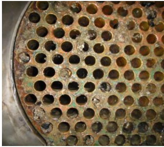
△ 해수 측 Tube side 내의 모습
