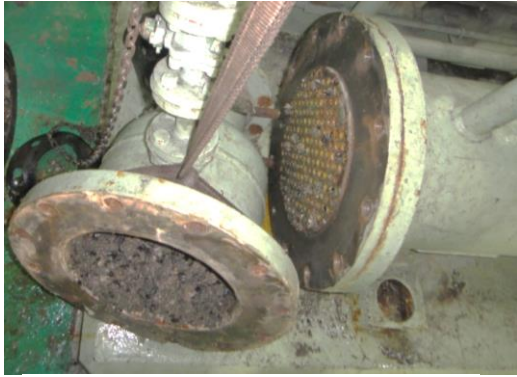
△ 해수 측 Tube side 내의 모습
