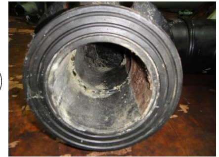
△ Chemical cleaning 시행 후 Image
