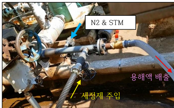
Online Cleaning 을 위한가설배관(Temporary pipe spool) 의 연결
