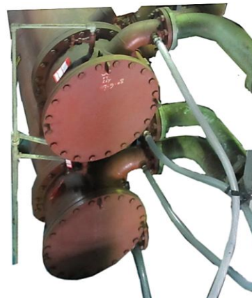
Oil Cooler 의 순환 세정 Hose 연결 모습
