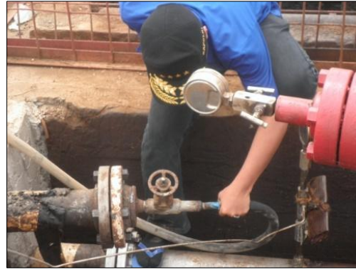
지하 매설 배관에 세정 가배관 설치
