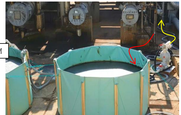
순환 세정을 위한 가설 세정제 탱크의 설치
