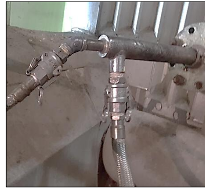
침출수 및 요소수 배관의 순환 세정을 위한 가설 배관 설치
