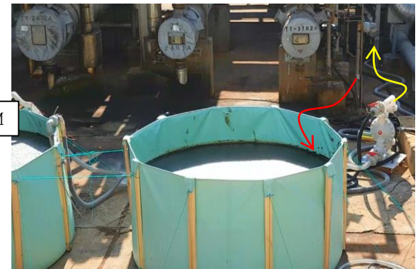
순환 세정을 위한 가설 세정제 탱크의 설치
