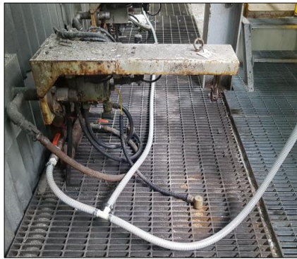
침출수 및 요소수 배관의 순환 세정을 위한 가설 배관 설치
