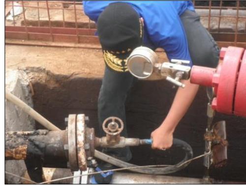
지하 매설 배관에 세정 가배관 설치
