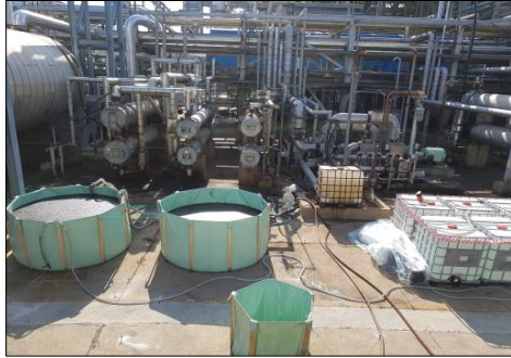
세정 작업 현장 전경
