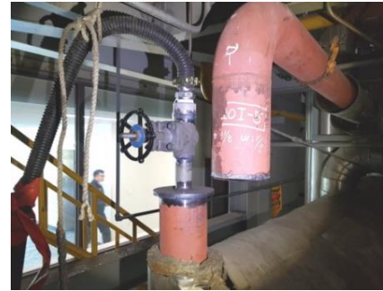
소각로 수관의 순환 세정을 위한 가설 배관 설치
