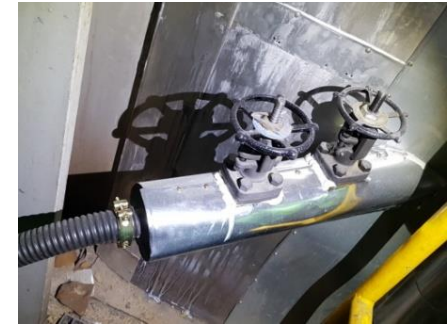
소각로 수관의 순환 세정을 위한 가설 배관 설치
